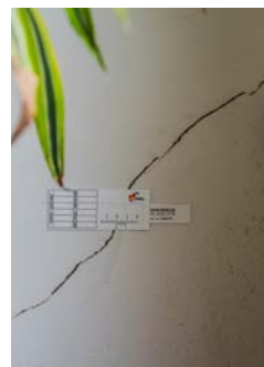
Probleem : Scheuren en verzakking van muur door een gebroken regenwater-afvoer
